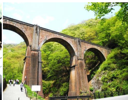
碓氷第三橋梁(安中市)
